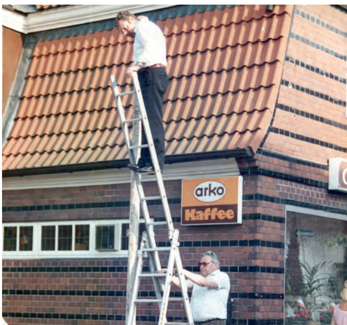
„Ohne Netz und doppelten Boden“ wurden die Einzelteile der Ehrenpforte zusammengebaut. Die Sicherung der Leiter übernahm „Sigg“ Meier, in luftiger Höhe zeigte Rainer Dose keine Höhenangst.
